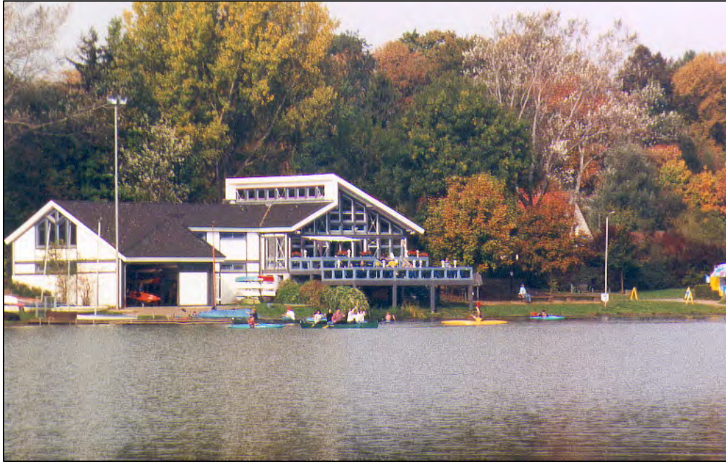
Foto 1: Der nordwestliche Bereich des Göttinger Kieselsee mit Restaurant.
